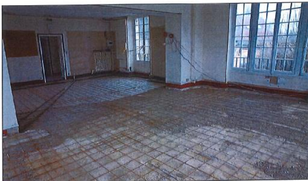
Espace de rez-de-chaussée du musée, Phase 1 des travaux © Musée Daubigny, Auvers-sur-Oise
